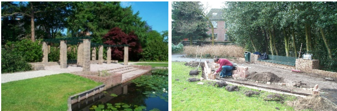
Afb. 93 en 94 Links: het plateau werd vernieuwd en de houten pergola vervangen door een stalen. Rechts: herstel van een van de zitjes, met een stalen bank. (Foto's G. Niesten)
