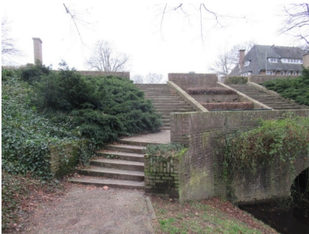
Gaten in de bloembakken voor ontwatering en muurplanten.
