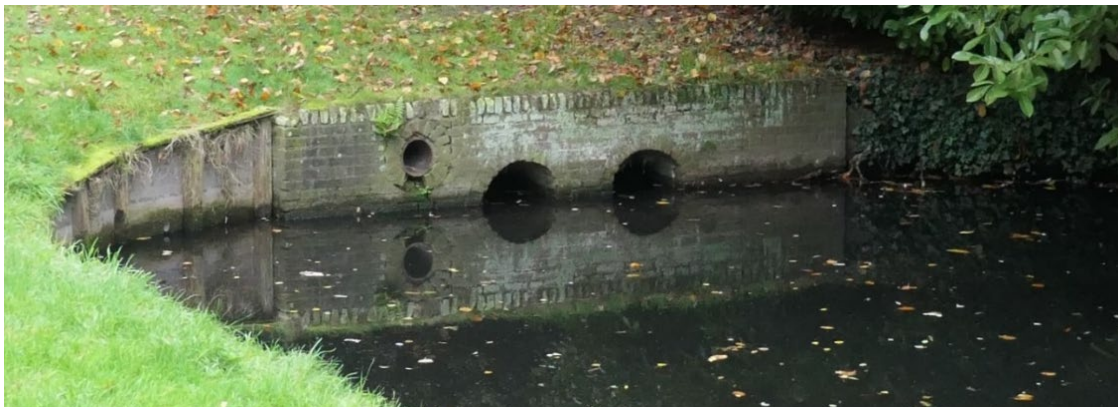
40. De muur van de duiker op het zuidende van de verkorte oostelijke zandvaart dient te worden gerepareerd.
