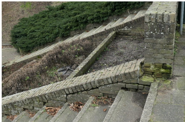
Zitje zuidwesthoek flagstone pleintje. Bank steekt over de muur, wat is het originele model? Gescheurde muur, losliggende stenen.
