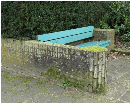
Zitje zuidwesthoek flagstone pleintje. Bank steekt over de muur, wat is het originele model? Gescheurde muur, losliggende stenen.
