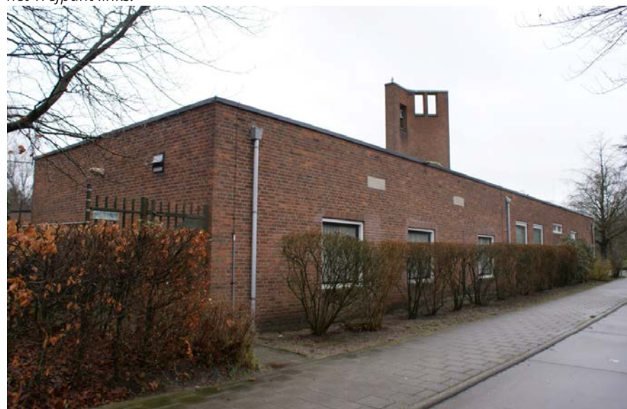
Afb. 23 Gevel van het ontmoetingscentrum langs de Ceintuurbaan. De drie vierkante vensters zijn gewijzigd, zoals het sporen in het metselwerk laten zien.
