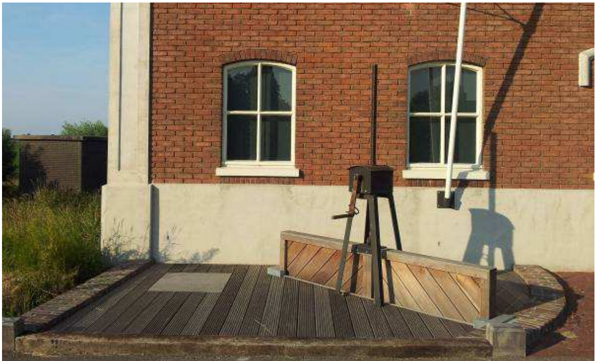
De reconstructie van de inundatieschuif met het originele windwerk voor de voorgevel.
