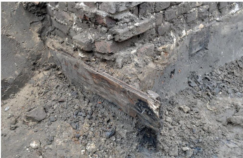
Detail van de noordwesthoek, waar een deel van de bekisting voor de betonplaat nog aanwezig is. De bekisting bestaat uit planken, die geplaatst zijn tegen paaltjes, welke in de grond zijn geslagen. Hierbij is gebruik gemaakt van draadnagels.
