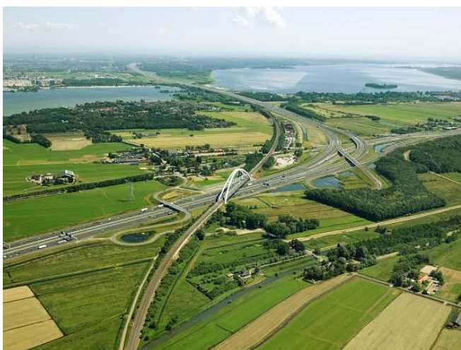
6.2 De Zandhazenbrug uit 2016 bij knooppunt Muiderberg is de spoorbrug met de langste overspanning in Nederland: 255 meter (foto: gemeente Gooise Meren).
