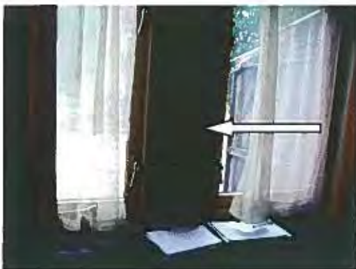
Foto 66: Sandwichpaneel tussen kozijnen van gebouw 27 (A25).
