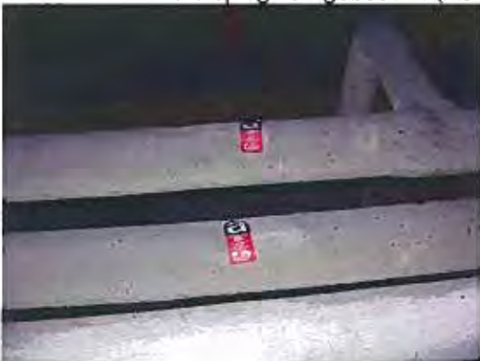
Foto 99: Leidingisolatie met asbest waarschuwingstickers in de technische omloop op de 1 e verdieping van gebouw 4 (A31).
