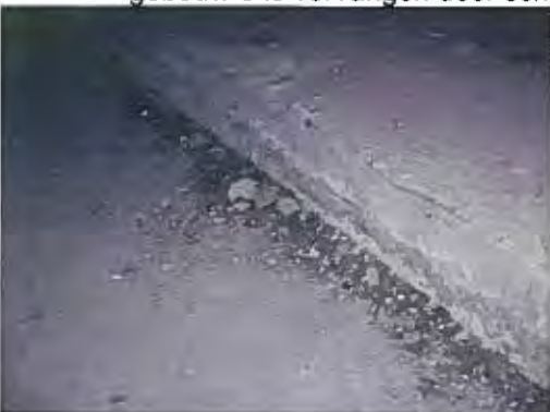
Foto 104: Restanten leidingisolatie (kurk en gips) op de vloer in de technische omloop van de 1 e en de 2 e verdieping van gebouw 6 (M29). Alle leidingisolatie in de technische omloop van gebouw 6 is vervangen door schuimisolatie.
