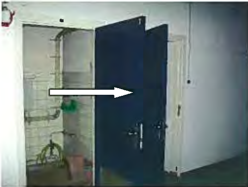
Foto 2: Brandwerende deur van de ketelruimte in gebouw 11 op begane grond (A1).
