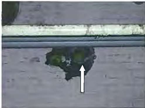
Foto 45: Leiding doorvoeren in de muren die afgekap't zijn daarin zit mogelijk isolatierestanten in ruimtes K001 en K005 van gebouw 13 (V12).
