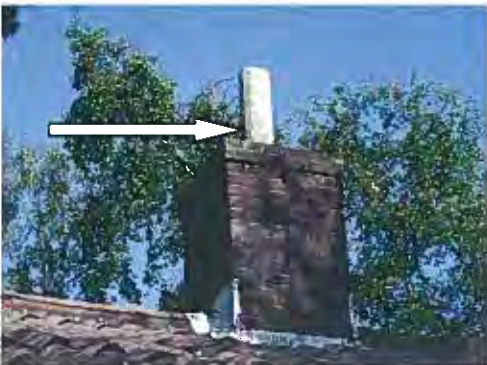
Foto 84: Rookgasafvoer gemetseld op een kanaal van gebouw 44 (op het rampenoefenterrein A24).
