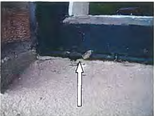
Foto 23: Kit zwart in buitengevel onder kozijn aansluiting vensterbank van gebouw 2 (M9).
