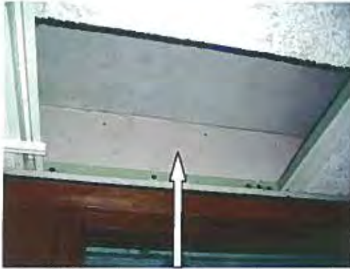
Foto 69: Strookjes plaat boven kozijnen boven het systeemplafond door het hele gebouw van gebouw 27 (A18).
