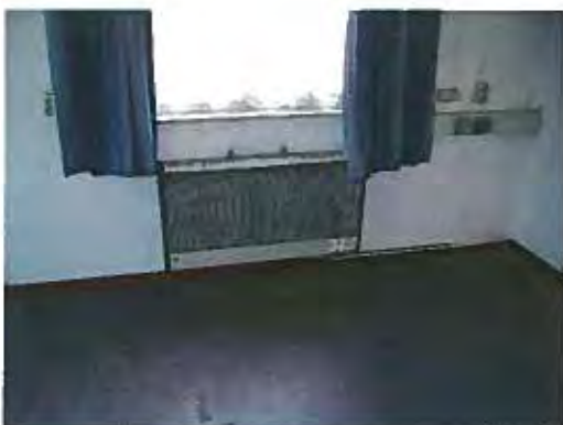
Foto 54: Dru gevelkachels in ruimtes 1, 2a, 2b van gebouw 20 (V21).
