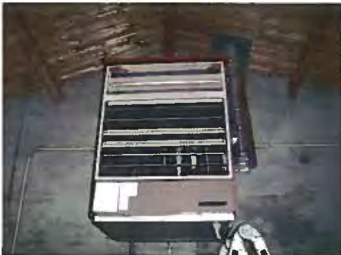
Foto 7: Profect luchtverwarming in gebouw 10 (V2).
