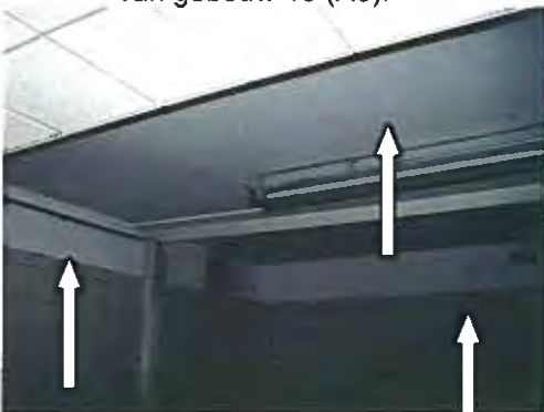
Foto 27: Plafondplaten en een strook op de wand van ruimte 26 op de begane grond van gebouw 13 (A6).
