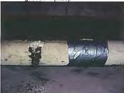
Foto 96: Beschadigde leidingisolatie (kurk met gips) in ruimte 209 op de 2 e verdieping van gebouw 1 (M26).
