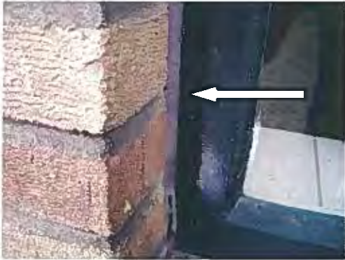
Foto 22: Kit grijs in buitengevel om stalen raamkozijn van gebouw 2 (M8).
