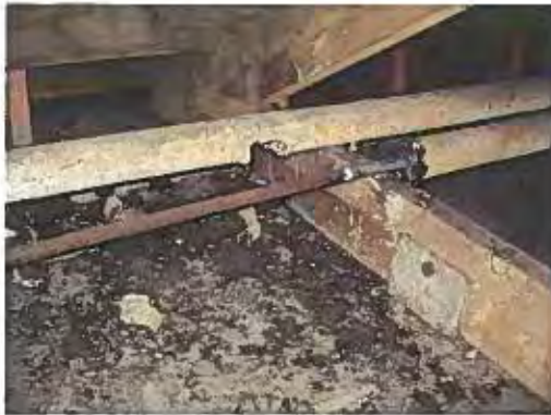
Foto 101: Ernstig beschadigde leidingisolatie (kurk met gips) in de technische omloop op de 1 e verdieping van gebouw 5 (M28).
