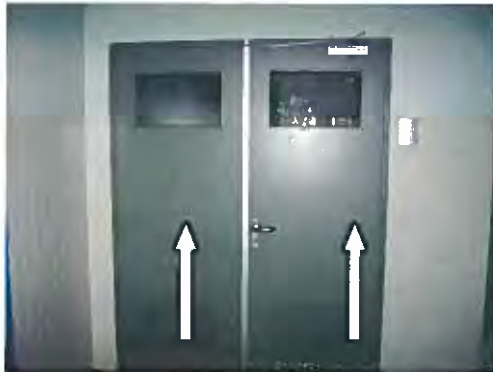
Foto 13: Beplating op deuren in ruimte 203 A van gebouwen 4 en 5 op de 2 e verdieping (A3).
