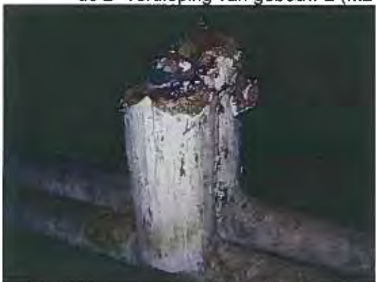
Foto 90: Ernstig beschadigde leidingisolatie (houtvezel met gips) in de technische omloop op de 2 e verdieping van gebouw 2 (M24).
