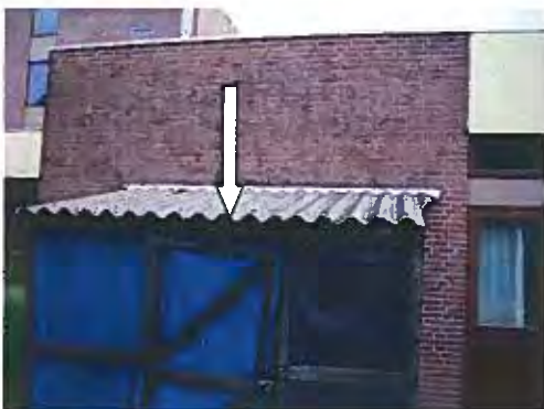
Foto 75: Golfplaten op het dak van gaaswand (A22).
