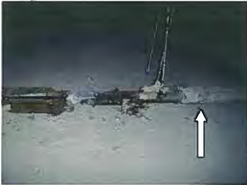
Foto 34: Leiding isolatie in kruipruimte onder ruimte 43 van gebouw 13 (M12). Tevens is de kelder volgespoten met schuimbeton hieronder is geen visuele inspectie mogelijk.
