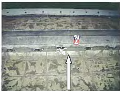
Foto 73: Golfplaat in beton gestort onder de Cv-ketels In ruimtes 270 en 326 van gebouw 27 (A21).
