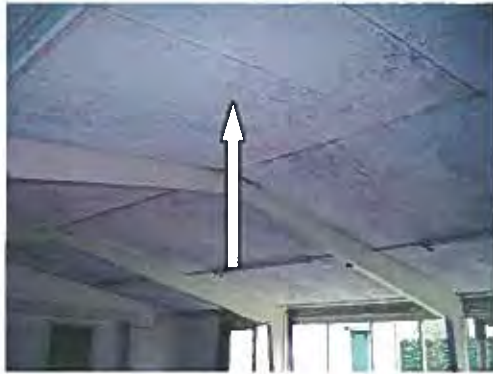
Foto 5: Witte coating op hout cementplaten in ruimtes 8 t/m 10 gebouw 11 (M3).
