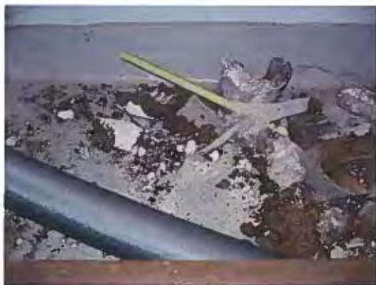
Foto 93: Restanten leidingisolatie (kurk met gips) op de vloer in de technische omloop op de 2 e verdieping van gebouw 2 (M25).
