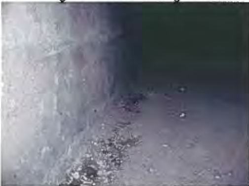
Foto 103: Restanten leidingisolatie (kurk en gips) op de vloer in de technische omloop van de 1 e en de 2 e verdieping van gebouw 6 (M29). Alle leidingisolatie in de technische omloop van gebouw 6 is vervangen door schuimisolatie.
