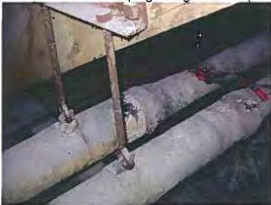
Foto 98: Beschadigde leidingisolatie met asbest waarschuwingstickers in de technische omloop op de 1 e verdieping van gebouw 4 (A31).
