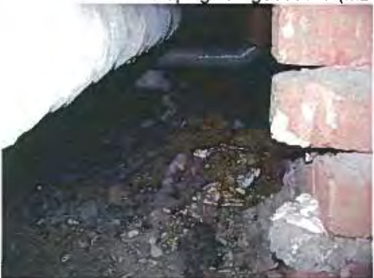
Foto 91: Restanten leidingisolatie (houtvezel en kurk met gips) op de vloer van de technische omloop op de 2 e verdieping van gebouw 2 (M24 en M25).
