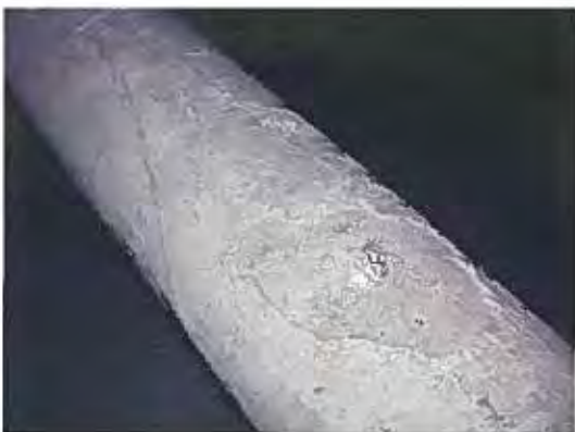
Foto 95: Beschadigde leidingisolatie in de technische omloop op de 2 e verdieping van gebouw 1 (M26).
