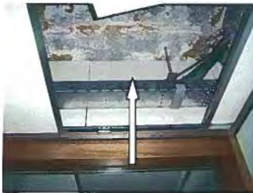
Foto 9: Brandschot boven klapdeuren in ruimte 002, 003, 102 en 103 van Gebouw 1 t/m 6 (M6).
