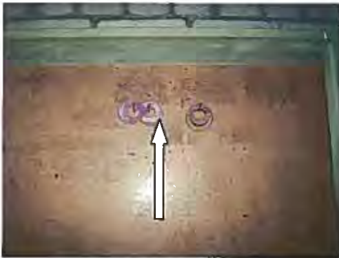
Foto 41: Los hangende pakkingen in kast in ruimte K006 van gebouw 12 (V11).
