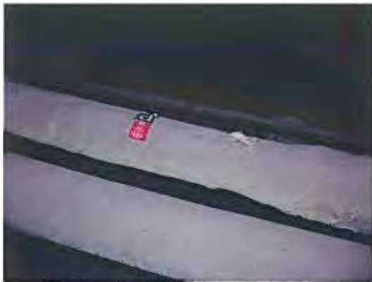
Foto 97: Beschadigde leidingisolatie met asbest waarschuwingstickers in de technische omloop op de 1 e verdieping van gebouw 4 (A31).
