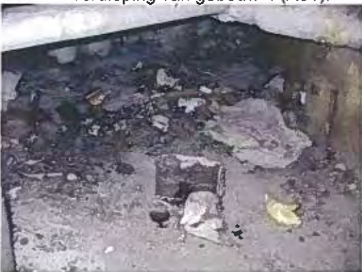
Foto 100: Diverse soorten restanten isolatiemateriaal op de vloer onder de geïsoleerde leidingen met asbest waarschuwingstickers.
