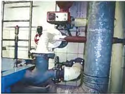
Foto 21: Pakkingen tussen flenzen in ruimte 203 op de 2 e verdieping van gebouw 2 en 3 (V5).
