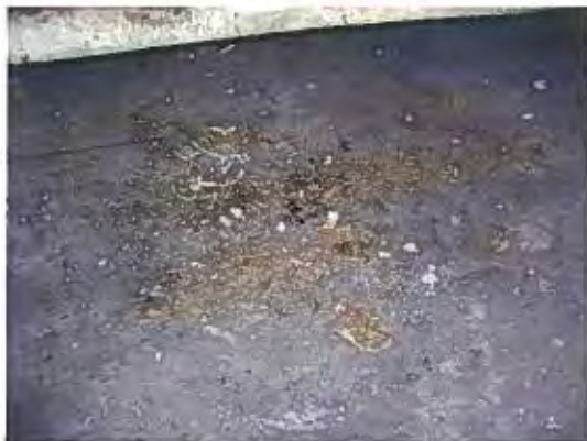
Foto 89: Restanten leidingisolatie (houtvezel met gips) op de vloer van de technische omloop op de 2 e verdieping van gebouw 2 (M24).
