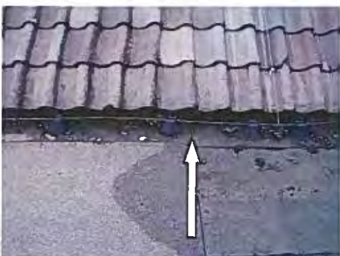
Foto 31: Kit onder bliksemafleider houders op het platte dak van gebouw 13 (M11).
