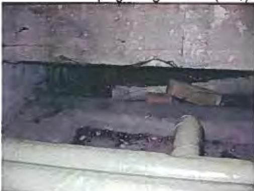
Foto 102: Restanten leidingisolatie (kurk en gips) op de vloer in de technische omloop van de 1 e en de 2 e verdieping van gebouw 6 (M29). Alle leidingisolatie in de technische omloop van gebouw 6 is vervangen door schuimisolatie.
