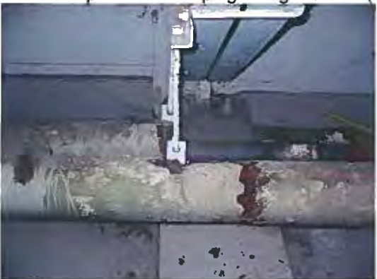
Foto 92: Ernstig beschadigde leidingisolatie (kurk met gips) in de technische omloop op de 2 e verdieping van gebouw 2 (M25).
