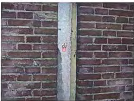
Foto 87: Bitumen met papier tegen de gevel aan de achterzijde van gebouw 19 (A29).
