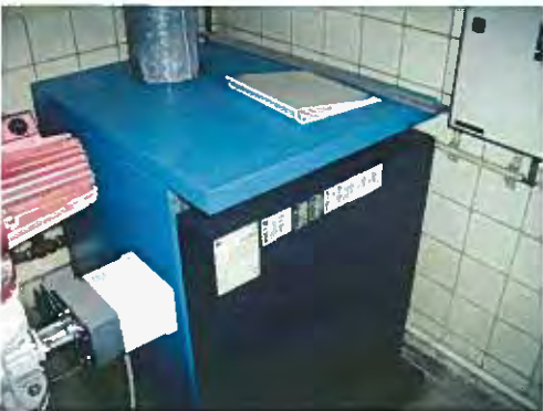
Foto 3: Buderus Cv-ketel in de Cv-ruimte van gebouw 11 begane grond (V1).
