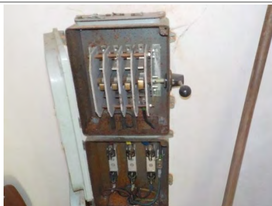
Zekeringen reeds verwijderd
