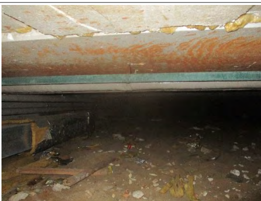
Kruipruimte met PVC en gietijzeren leidingwerk
