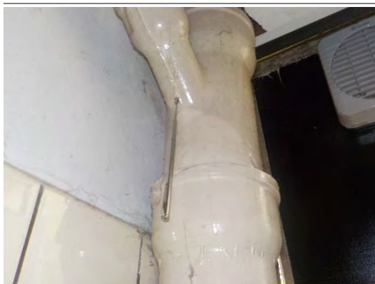
Riolering is van gietijzer
