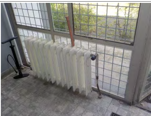
In de radiatorpakking is geen asbest aangetoond
