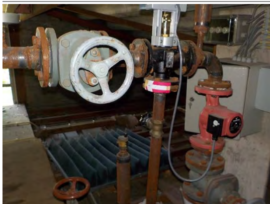
Asbestvrije pakkingen op de vliering
