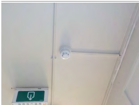
Brandmelder niet radioactief
