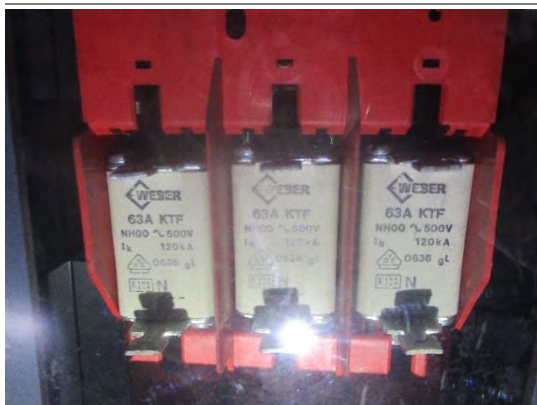
Meszekeringen zijn niet asbesthoudend
