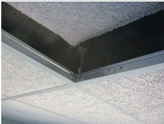
Houtwolcement plafondplaten
