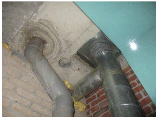
Metalen en PVC afvoeren/ ontluchtingen
