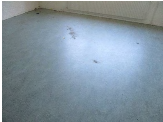
Linoleum vloer op beton
