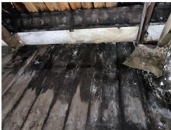
Figuur 2 – De 2 e verdiepingvloer zeer nat en plaatselijk rotte delen
