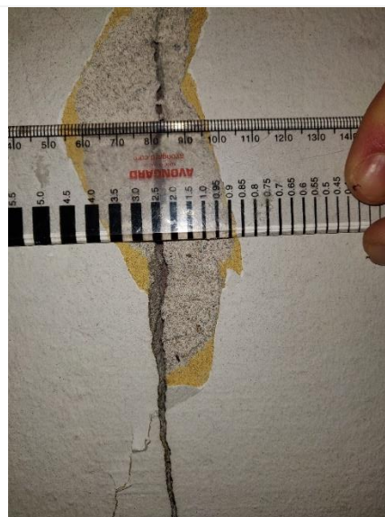
Figuur 6 – De scheurwijdte is ca. 2,5 mm
