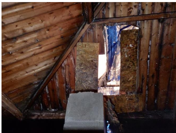
Figuur 4 – Gaten in de kapconstructie, welke de oorzaak zijn van de vochtproblemen
