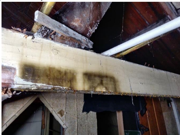
Figuur 3 – Spanten dakconstructie met schimmelvorming
