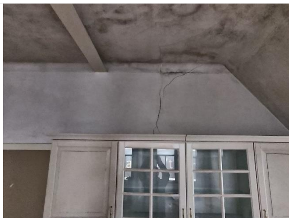
Figuur 5 – Scheurvorming in metselwerk wand 1 e verdieping
