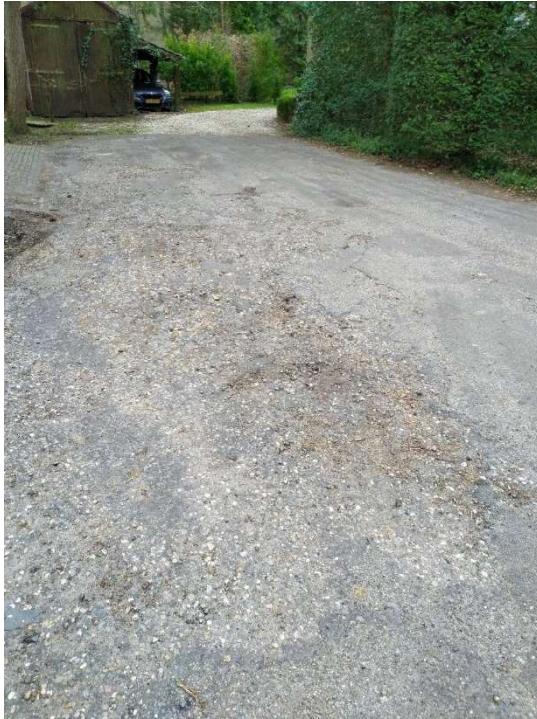
Fig 5 Toplaag is volledig verdwenen
