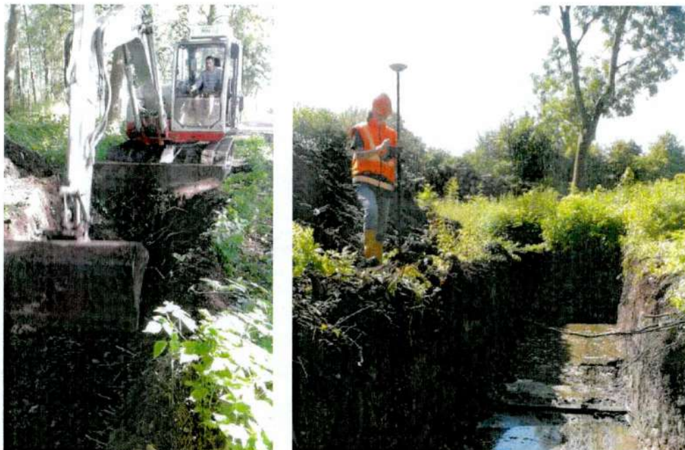
Afb. 4. Links het laagsgewijs ontgraven van het vlak; rechts het inmeten van de aangelegde werkputten met behulp van een GPS.
