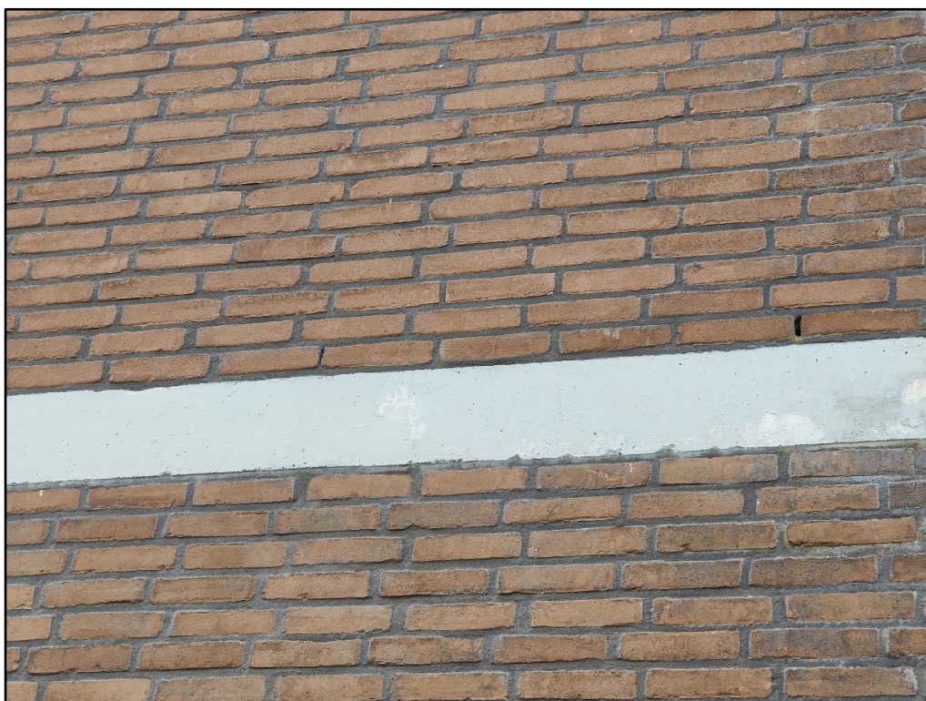
Figuur 2 De open stootvoegen in het schoolgebouw zijn naar schatting circa 2cm breed, waardoor grotere vleermuizen als de laatvlieger geen doorgang kan vinden.
