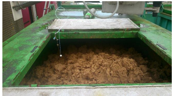
Slibcontainer bij slibontwatering (figuur 9 pagina 16)
