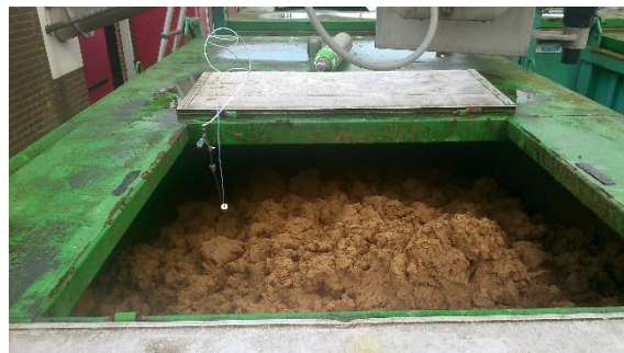
Slibcontainer bij slibontwatering (figuur 9 pagina 16)
