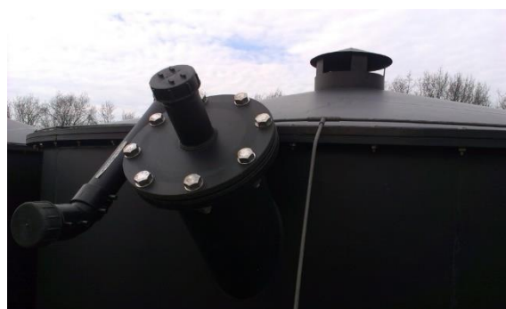
Afblaaspunt HIFI-filter (figuur 6 pagina 14)
