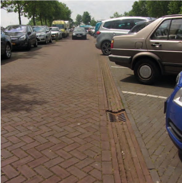
rijloper parkeerplaats gebakken dikformaat keperverband met enkele strek rood-bruin gemeleerd voorstel: VanderSanden Cadiz DF voorzien van inrit banden, standaard hardsteen(kleur)
