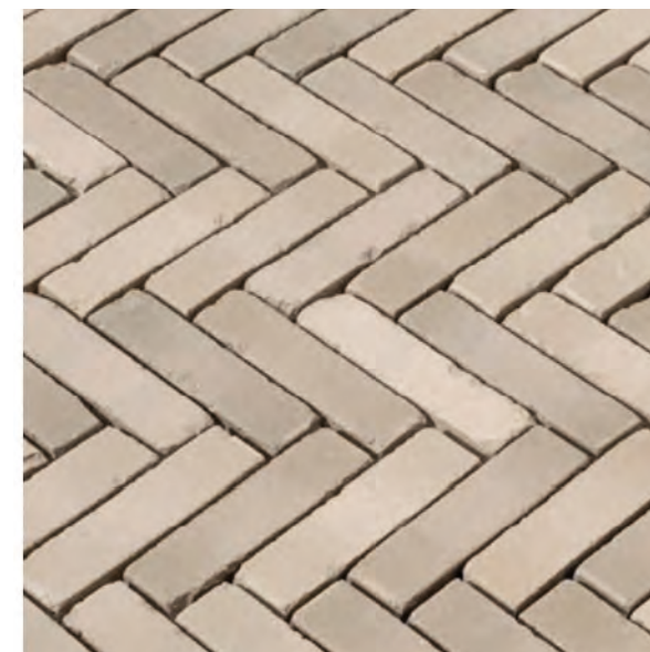
gebakken lingeformaat elleboogverband met dubbele strek, geel gemeleerd voorstel: VanderSanden Gromo Antica voorzien van trottoirbanden, standaard hardsteen(kleur)
