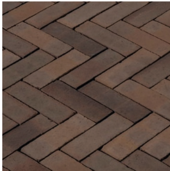
figuur 36: parkeerplaats gebakken dikformaat elleboogverband met enkele strek, vak-
