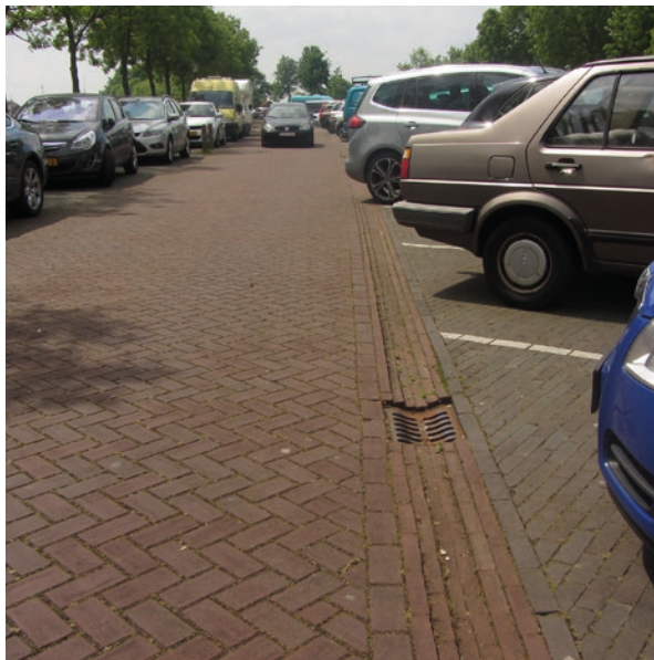
figuur 35: rijloper parkeerplaats gebakken dikformaat keperverband met enkele strek
