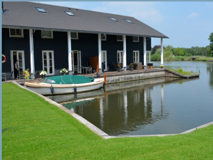
veranda aan water meeontworpen in architectuur
