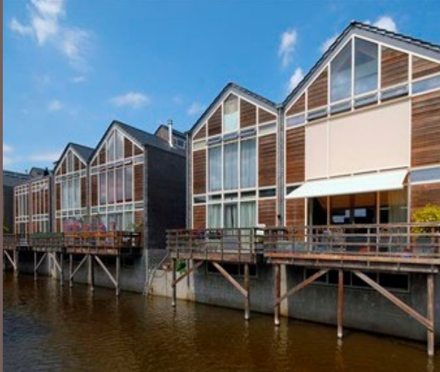
stenen basement, houten gevel en vlonders, ritmisch volume
