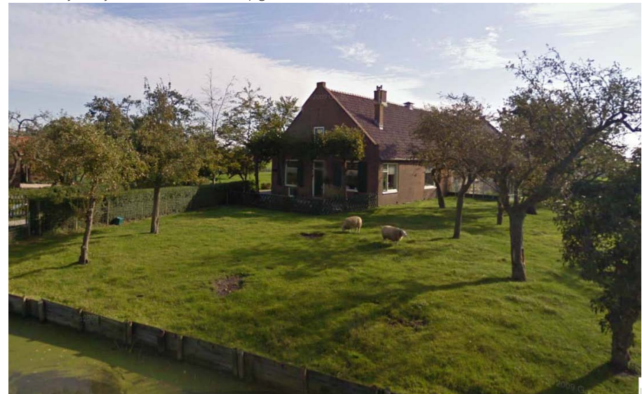
Afbeelding 11. Erf langs de Noordpolderweg; Het voorerf is onbebouwd en eenvoudig ingericht. Foto: I. Bos
