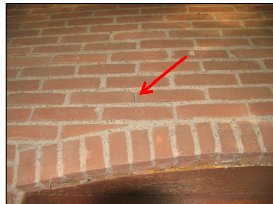
Links: afgebeten vlindervleugels van een dagpauwoog. Rechts: open stootvoeg in gebouw I (rode pijl). Bron: SAB.
