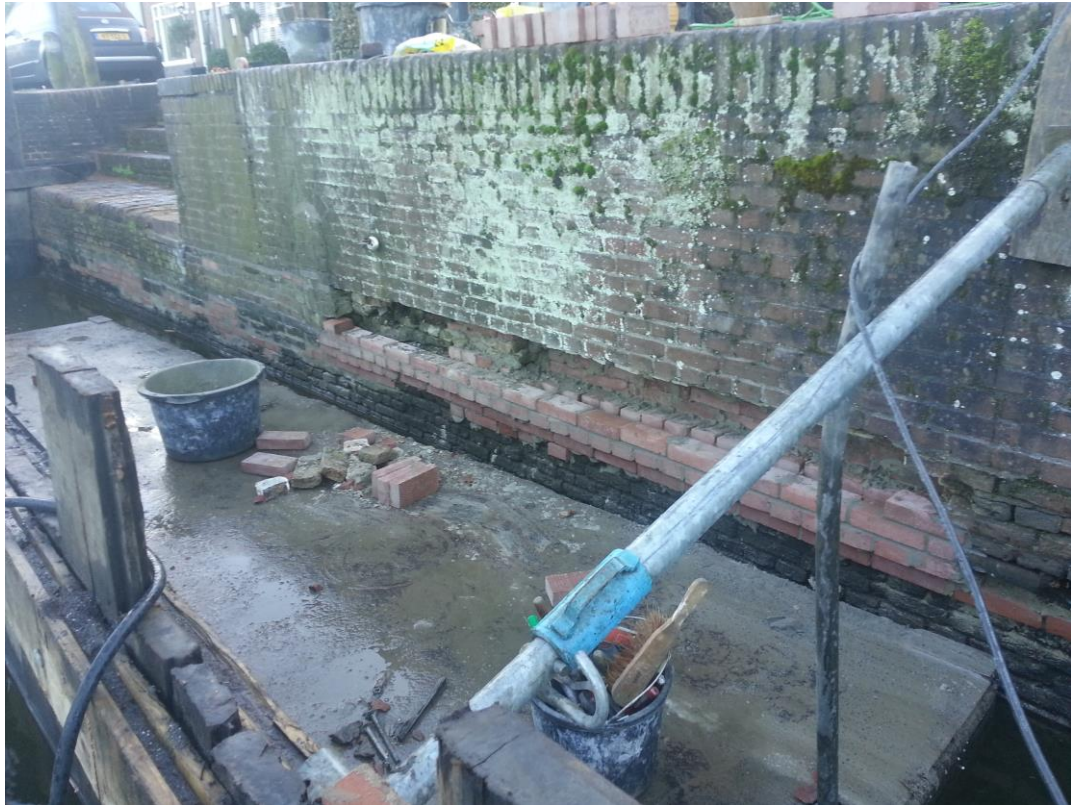
Foto 3: uitvoering herstelwerkzaamheden en toegepaste hersteltechniek
