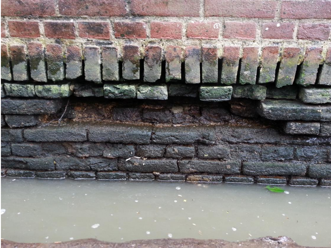
Foto 1: detailfoto van materiaalgebruik en de metselverbanden in de bestaande kademuur
