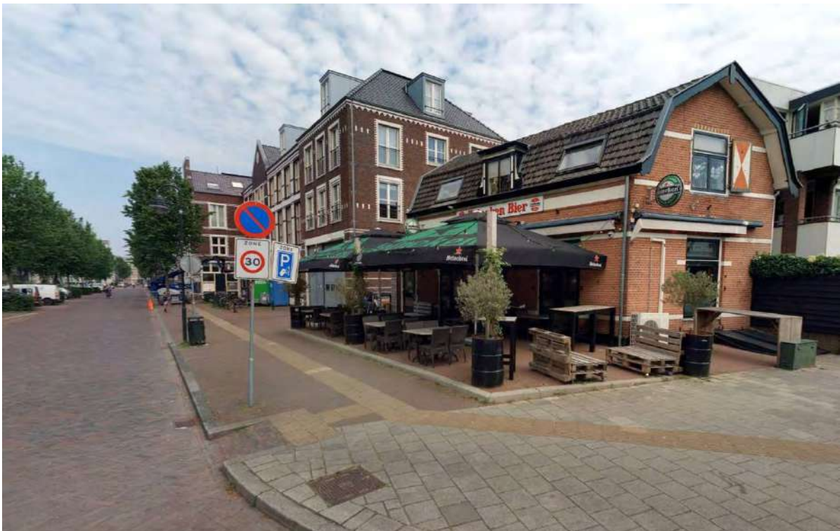
Figuur 2.2: Terreinsituatie onderzoekslocatie (bron: cyclomedia)
