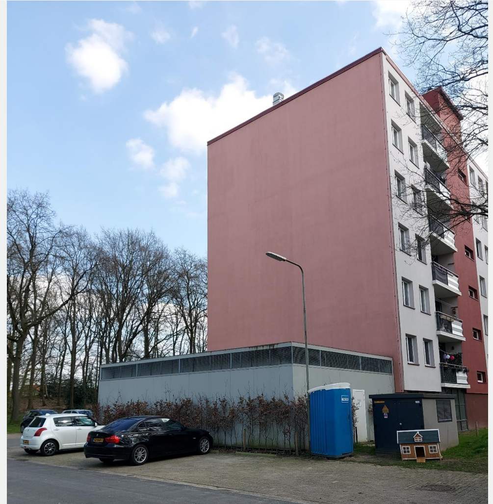
250kW HT lucht-water warmtepomp van Servex-Feenstra Voorziet 48 appartementen van warmte en warm tapwater
