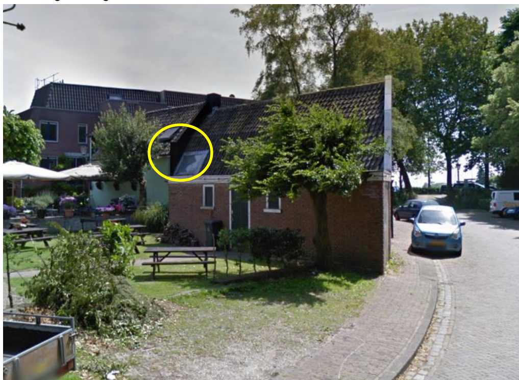
Figuur 10. Foto noordgevel object Weesperstraat 84 (bron Google, juni 2017). Hieruit blijkt dat de eerste bouwlaag geen ramen of deuren bevat en dat geen tuin aanwezig is die relevant zijn voor de situeringswaarde. Er is alleen sprake van dakramen op de tweede bouwlaag (geel omcirkeld).
