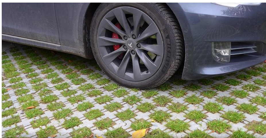
Foto 4; De foto toont een voorbeeld van een halfverharding (Greenpro).
