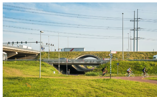
Referentie Fietstunnel A12-N209
