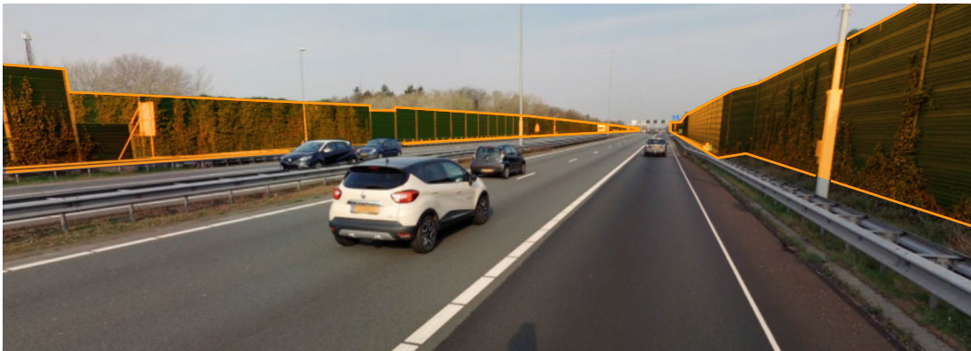
Huidige situatie A1 bij Crailo volledig 'ingepakt' in geluidsschermen
