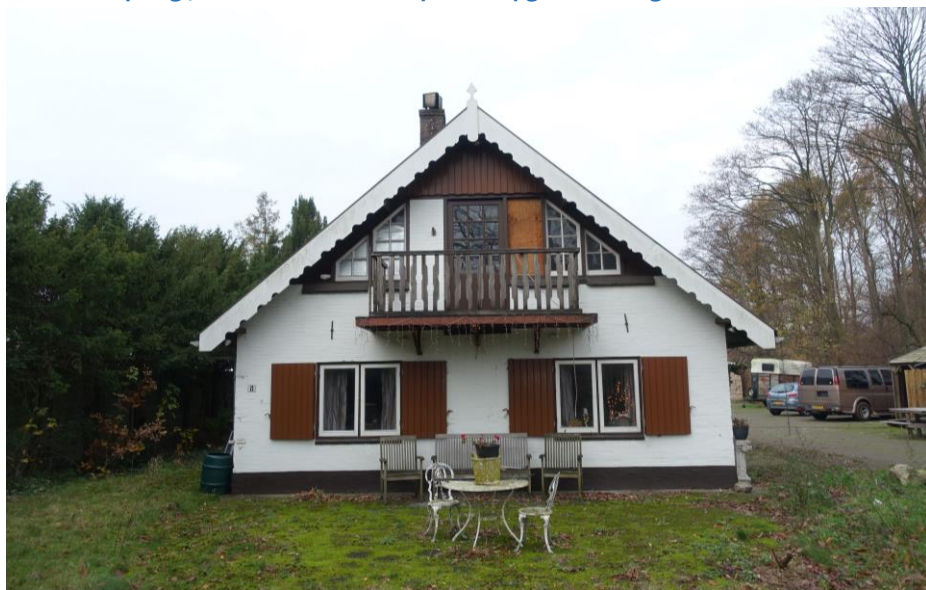
Franse Kampweg 30 A-C. Overzicht oostgevel. FH MAB 24-11- 2020
