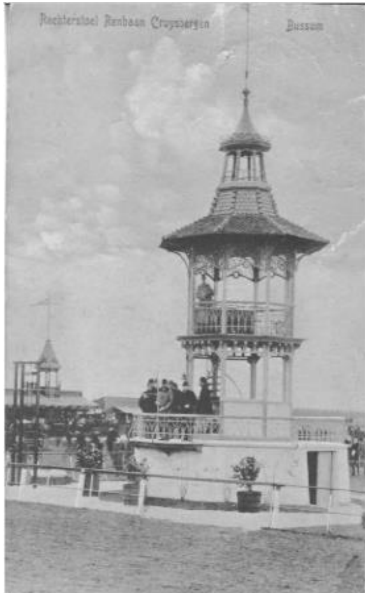
De in geklonken ijzer en siersmeedwerk uitgevoerde rechterstoel/scheidsrechterstoren. 1905. Op de achtergrond de consumptietent. Beeldbank gooienvechthistorisch.nl Fotocollectie Winthorst (Bussum) SSAN092W N8.033.1
