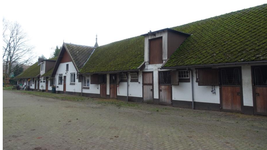
Franse Kampweg 30 A-C. Overzicht noordgevel vanuit het noorden. FH MAB 24-11- 2020
