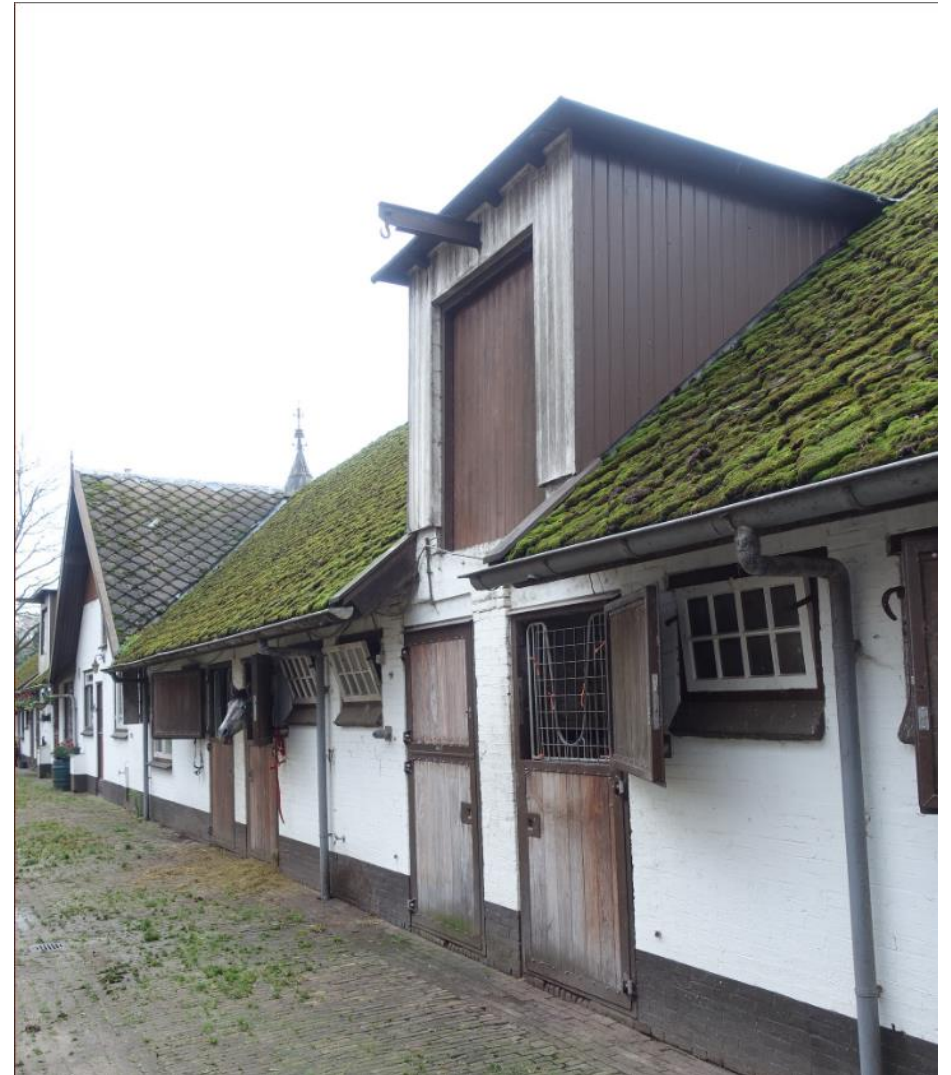
Zicht op de noordgevel van het stalgedeelte. De indeling van de gevel en de stalramen zijn nog oorspronkelijk, de deuren zijn gewijzigd en vernieuwd. De stenen dakkapel is gewijzigd en omkleed met houten delen. FH MAB 2020
