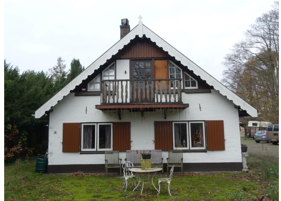
De oostelijke kopgevel met de enige jaren terug nog door Wiegmans gewijzigde windveren en balkonbalustrade, waardoor de gevel min of meer het uiterlijk kreeg van een Zwitsers chalet. FH MAB 2020
