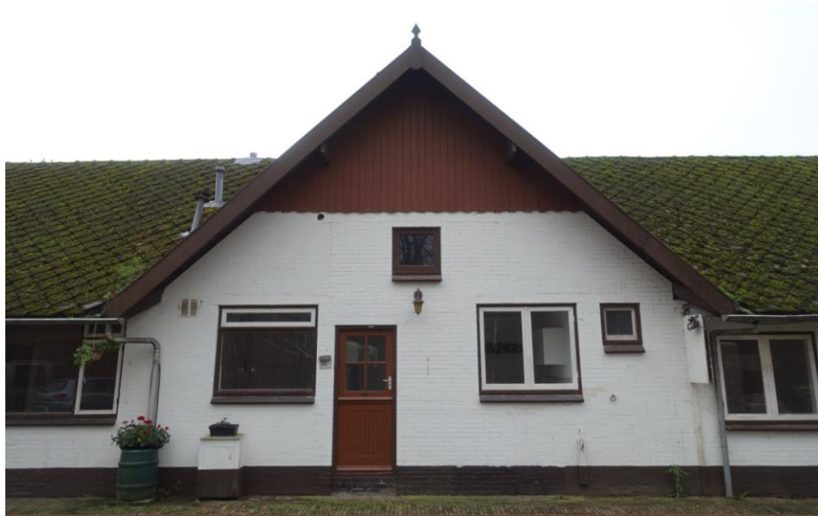
De noordgevel van de middenbouw met de in 1962 ten behoeve van de inpassing van een woning aangebrachte vensters en deur. FH MAB 2020.
