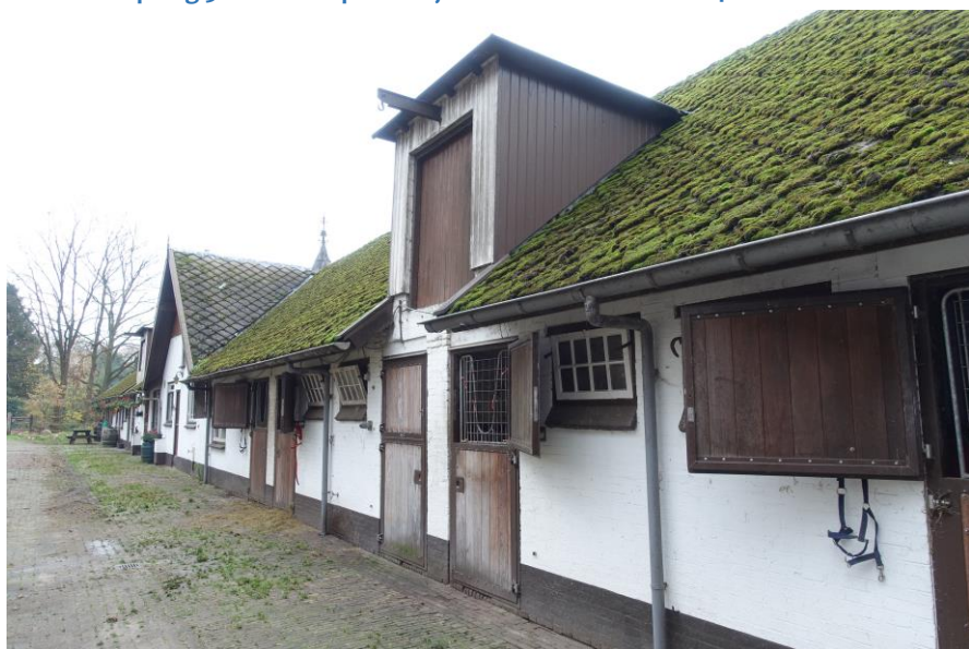
Franse Kampweg 30 A-C. Noordgevel vanuit het noordwesten. FH MAB 24-11- 2020
