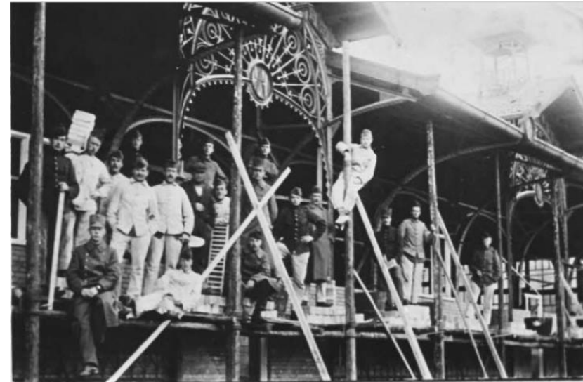
Militairen poseren tijdens het metselen van muren waarbij de open ijzeren constructie van de tribune werd afgesloten ten behoeve van een gebruik als stalgebouw. Beeldbank gooienvechthistorisch.nl Fotocollectie Winthorst (Bussum) SSAN092W N8.033.3
