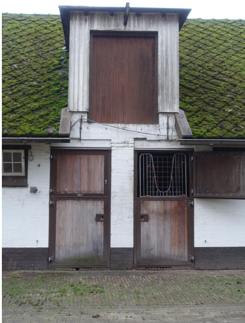
Franse Kampweg 30 A-C. Dakhuis en staldeuren. FH MAB 24-11- 2020
