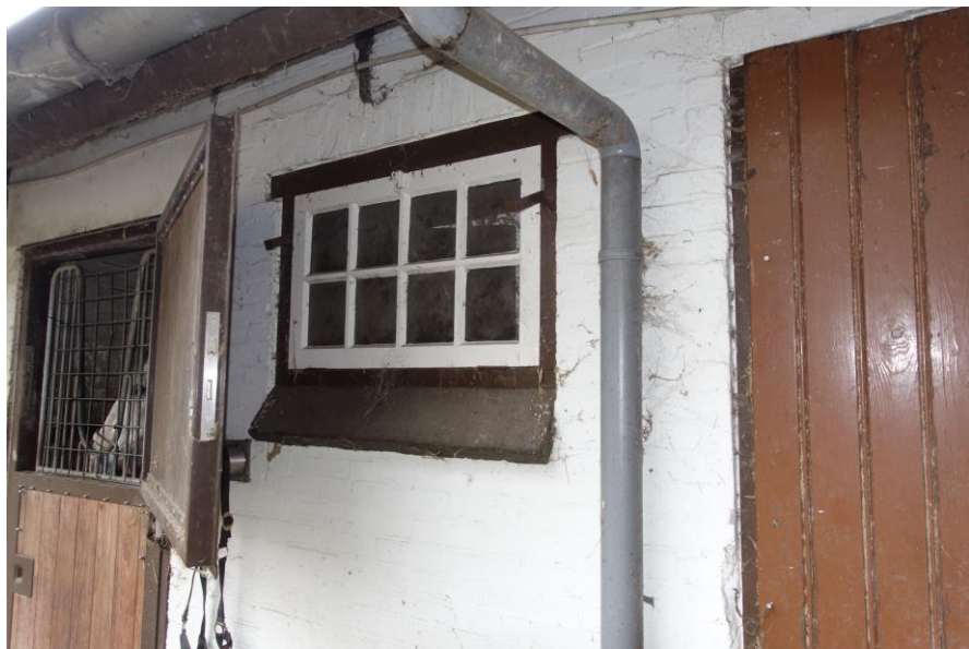
Franse Kampweg 30 A-C. Oorspronkelijk stalvenster. FH MAB 24-11- 2020
