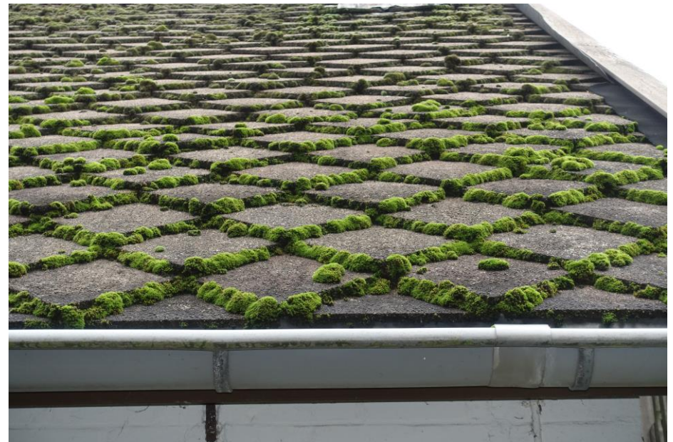
De ruitvormige betonpannen van Franse Kampweg 30a-c. FH MAB 2020
