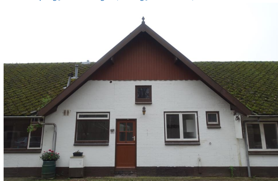
Franse Kampweg 30 A-C. Noordgevel middendeel, (woning 30c). FH MAB 24-11- 2020
