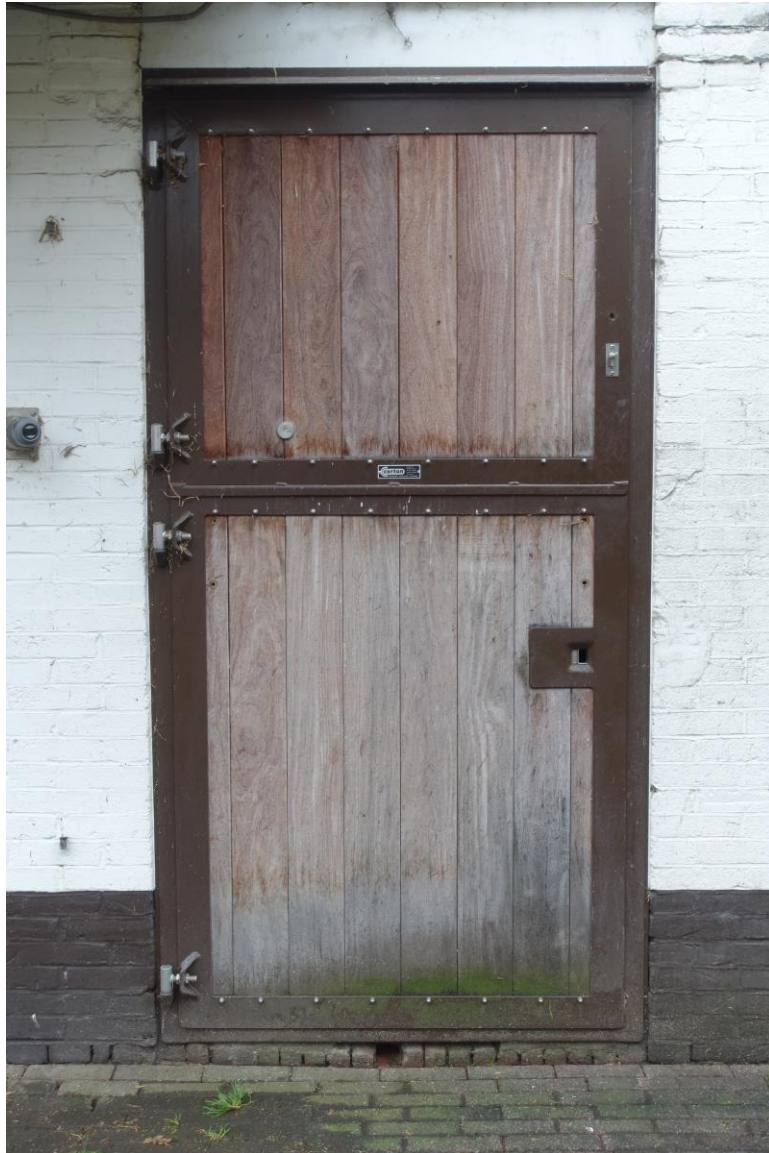
Een vernieuwde, in een stalen kozijn en stalen omraming gevatte staldeur van een paardenbox. FH MAB 2020
