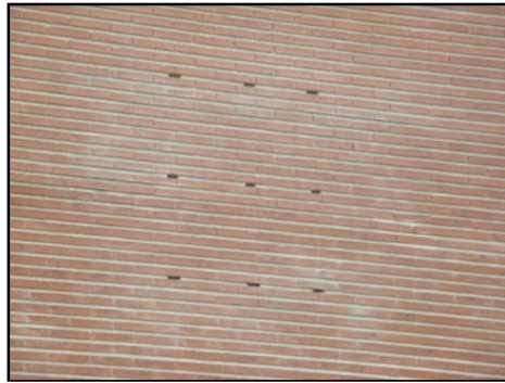
Voorbeeld open stootvoegen in de gevel van een gebouw
