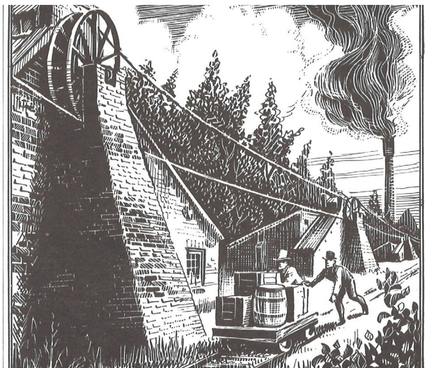
33. De werkgebouwen langs de productielijnen waren voorzien van stevige steunberen met wielen, die via koorden en een stoommachine centraal aangedreven konden worden (Buskruytmaeckers).
