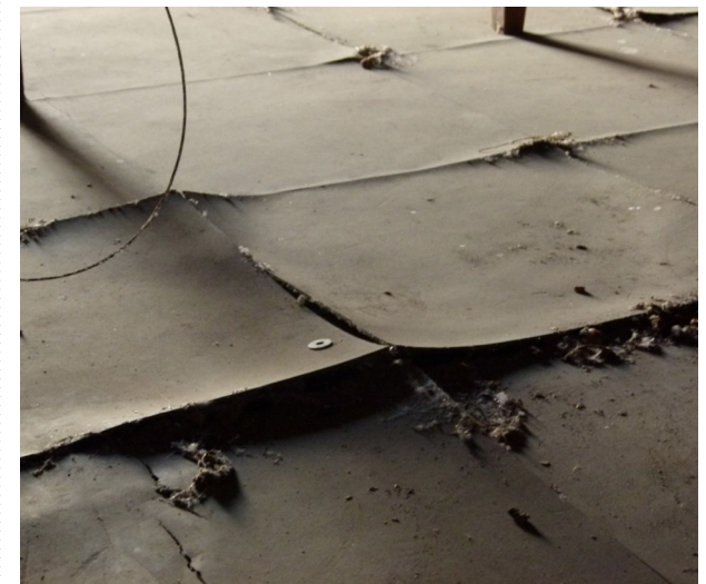
41. De vloer van het westelijke magazijn is bekleed met rubber tegels.
