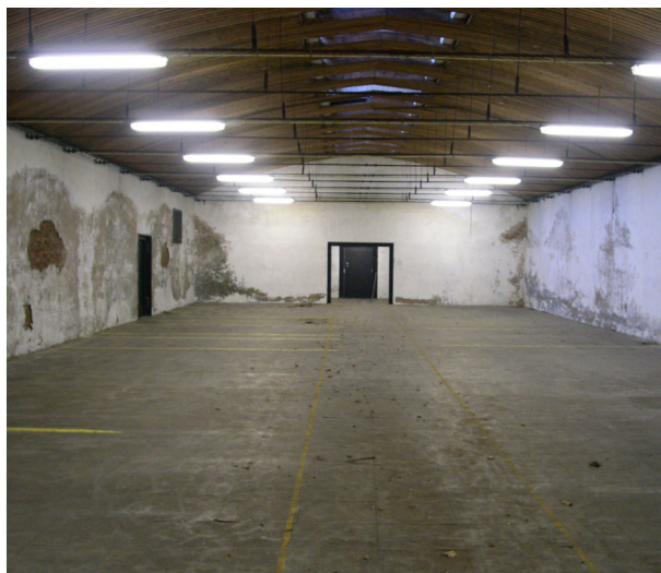
40. Het interieur van het westelijke magazijn met een schaaldak.
