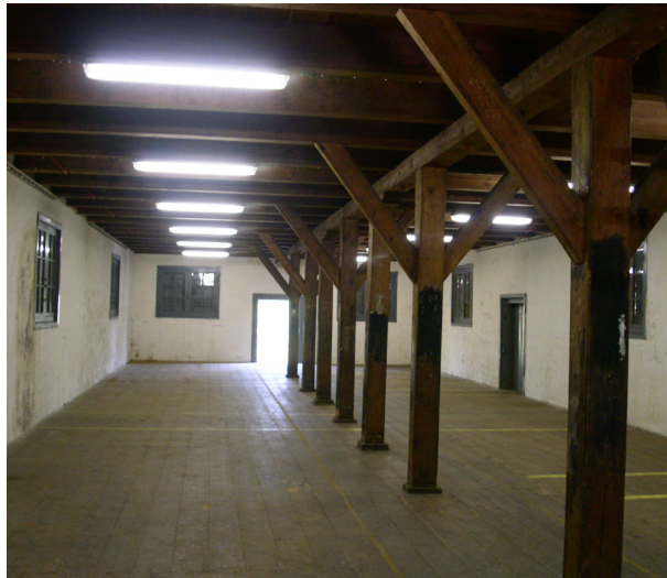
37. Het interieur van het oostelijk magazijn met een forse houten constructie en een ruime zolder.
