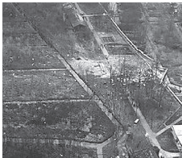
34. Schade na de ontploffing van 1972 met een restant van een gebouw langs productielijn 1 bovenaan (ANP).
