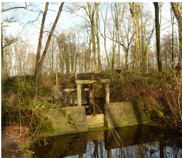
20. Sluis midden is een betonnen damsluis uit circa 1930 (volgens het rapport MSP).
