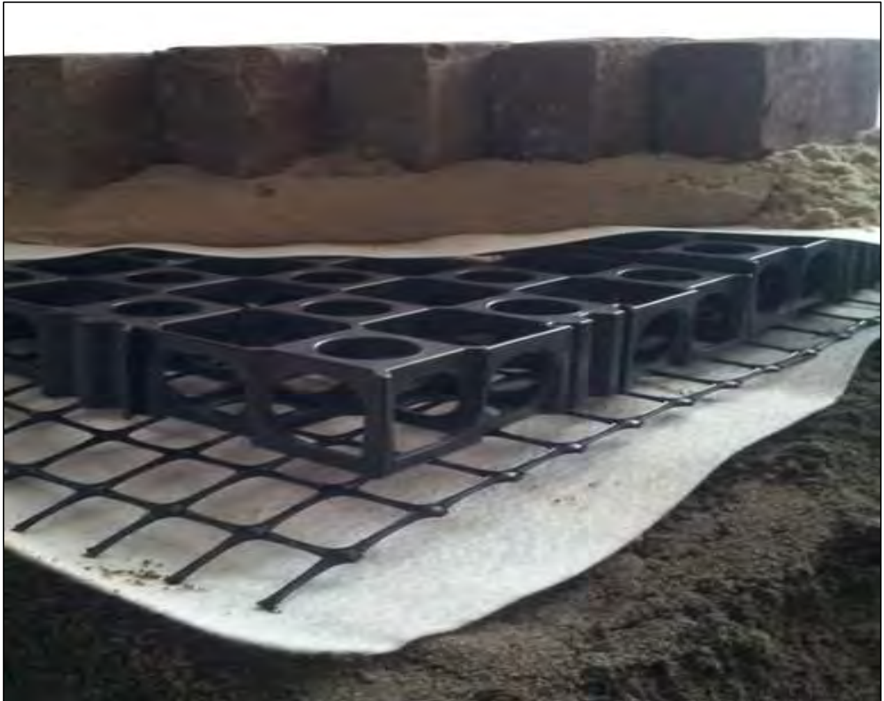
Afbeelding 4: voorbeeld van een sandwichconstructie
