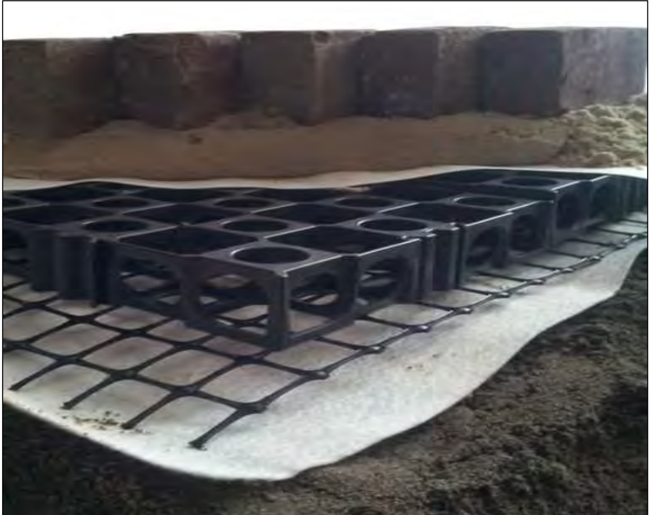
Afbeelding 4: voorbeeld van een sandwichconstructie
