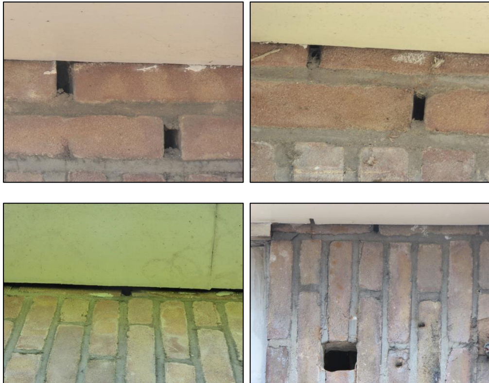
Open stootvoegen, kieren onder de dakrand en een gat in de muur dat toegang geeft tot de spouwmuur in de oostelijke loods.
