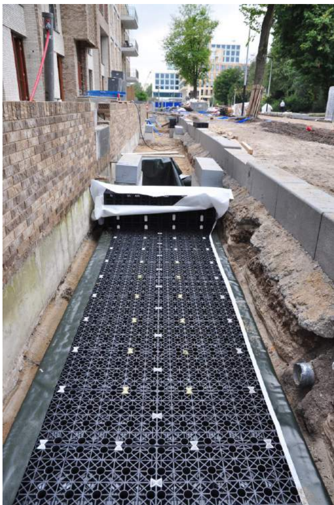
Voorbeeld van de aanleg van een waterbuffer onder maaiveld
